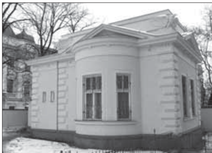
Janáčkův domek v těsném sousedství Centra VUT v Brně byl kompletně opraven.
