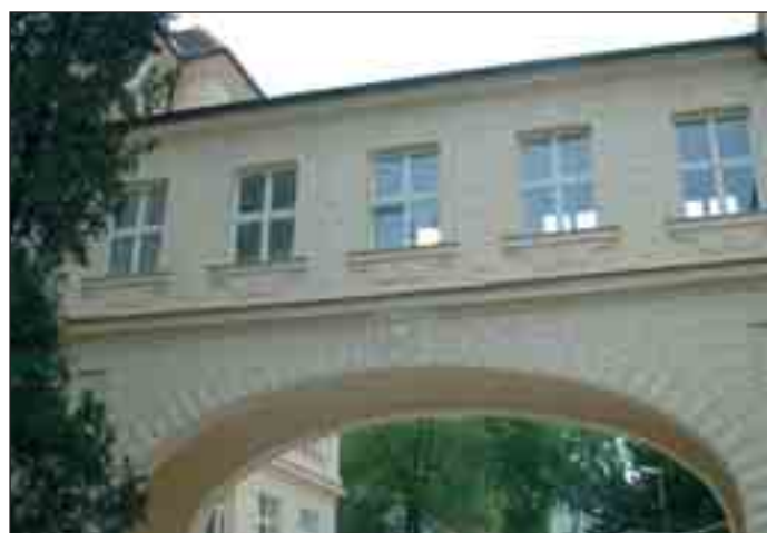
Investorem rekonstrukce hlavní budovy A Fakulty stavební bylo VUT v Brně.
