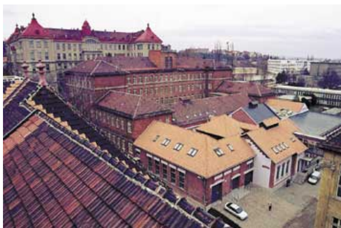
Areál D3 v komplexu budov FAST
